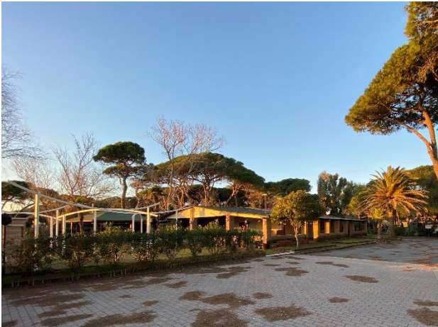
Figura 18 Fabbricato F1 – area ristorante allo stato attuale
