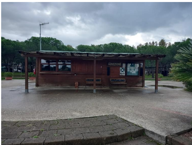
Figura 4 Fabbricato F13 – nuova direzione/reception allo stato attuale
