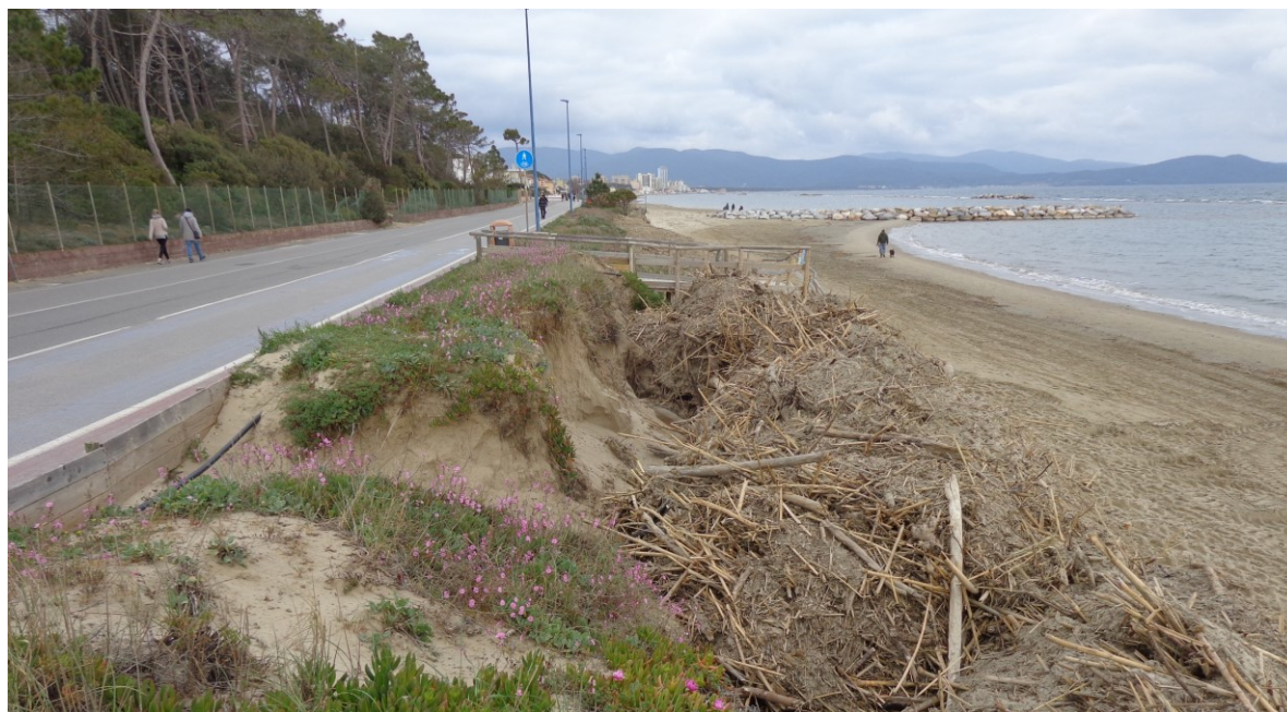
Foto 4 Intensi processi di erosione dunale costiera nel tratto adiacente il “Villaggio svizzero”
